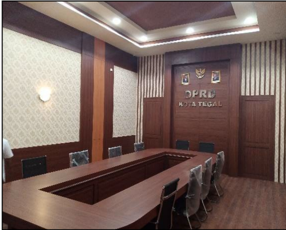
Gambar 7: Wallpanel pada interior DPRD Kota Tegal (Sumber: Dokumentasi penulis, 2023)
